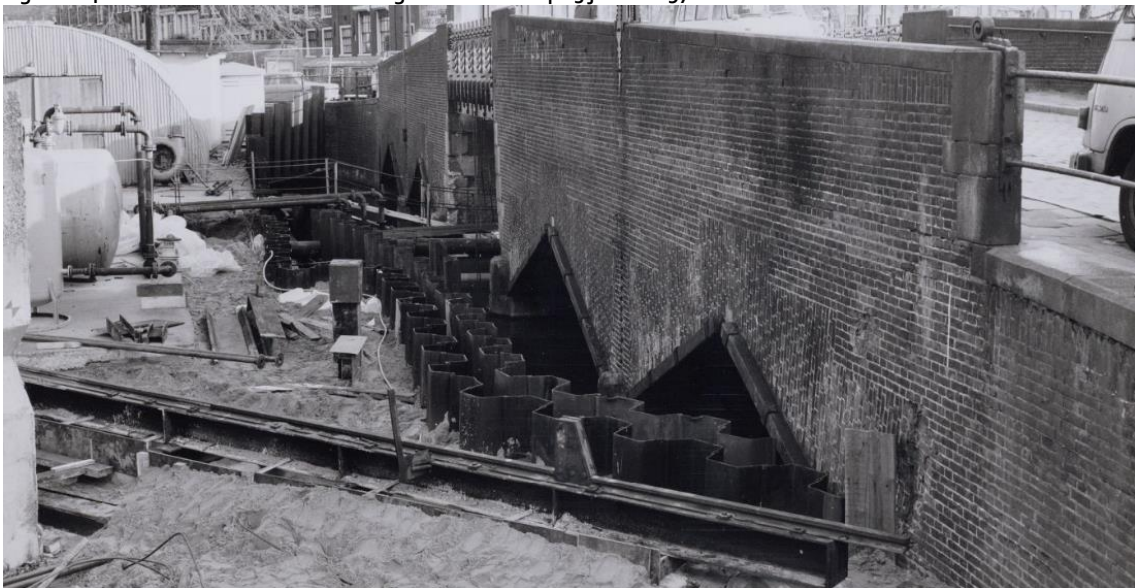
Figuur 124: Werkzaamheden voor de aanleg van de metro op 23 januari 1976
