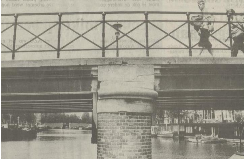
Figuur 137: Stalen noodconstructie brug 280 in 1991
