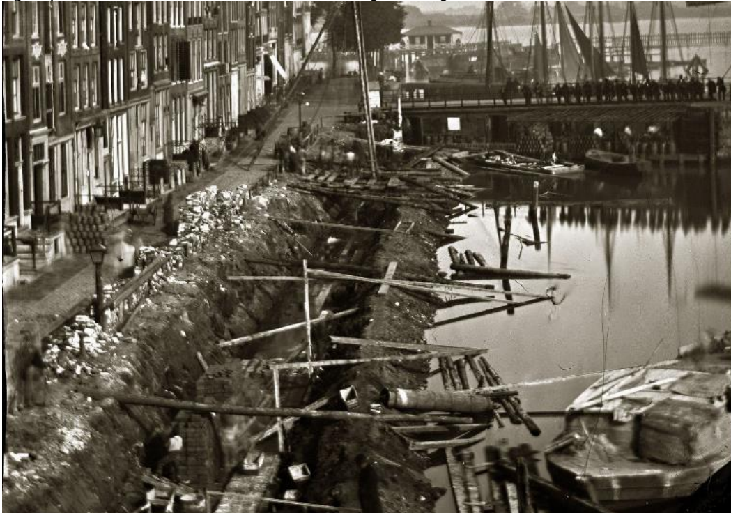
Figuur 41: Werkzaamheden aan kademuur Kromme Waal 9-21 in 1863
