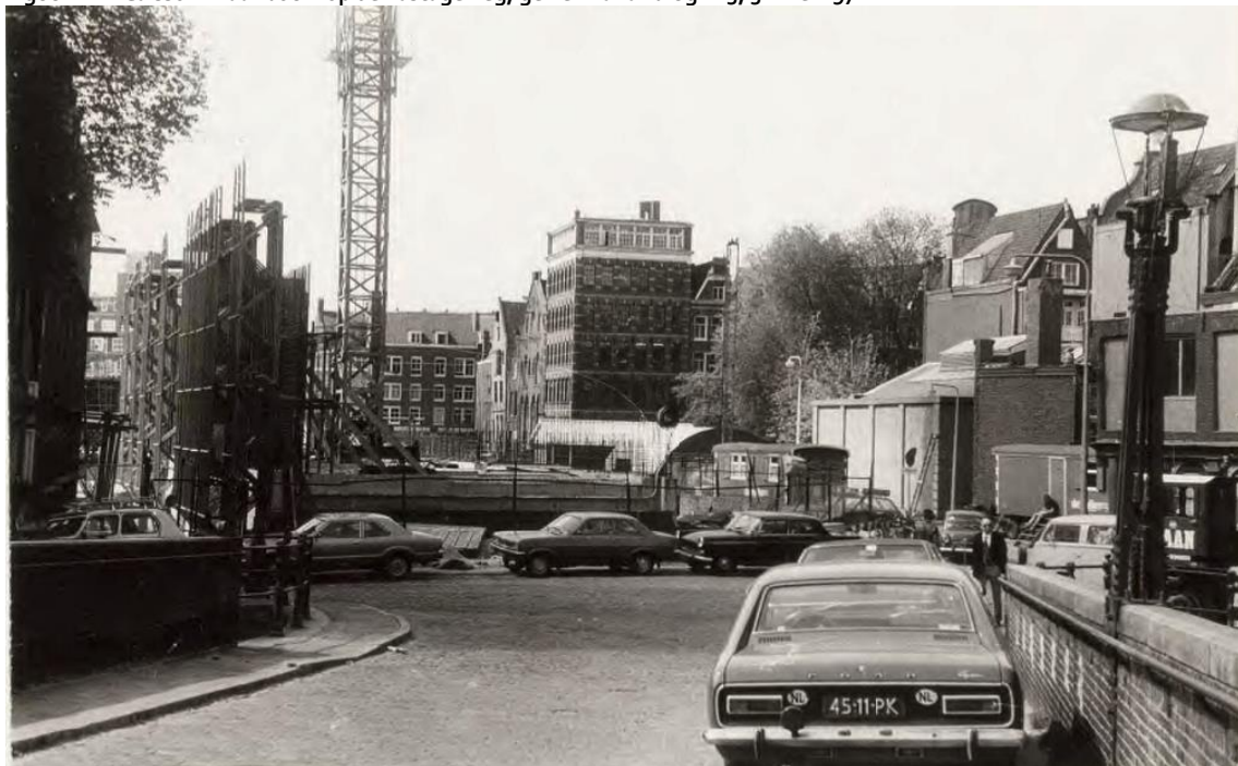
Figuur 128: Caisson in aanbouw op de Lastageweg, gezien vanaf brug 283, 31 mei 1976
